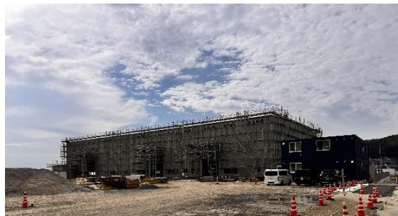
(防府新工場-建設中外観)
